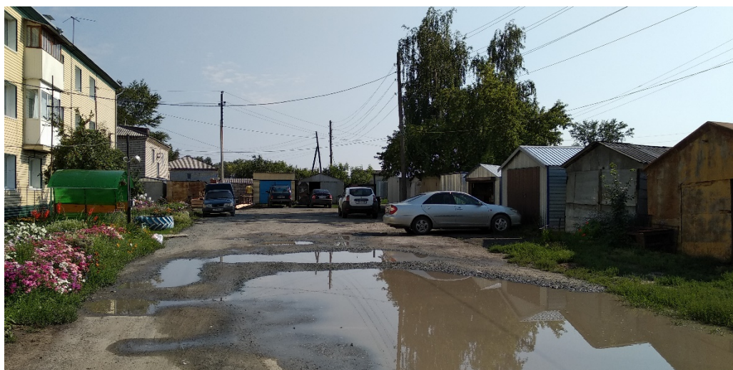
Рисунок 1 – Разрушенное покрытие на территории дома
